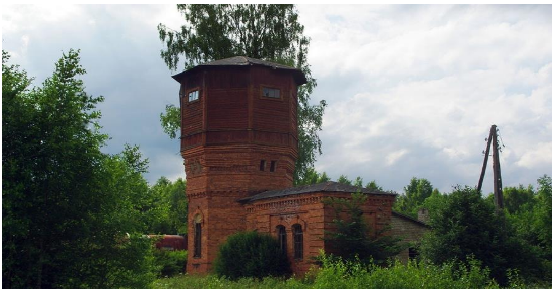
Водонапорная башня для заправки поездов.
